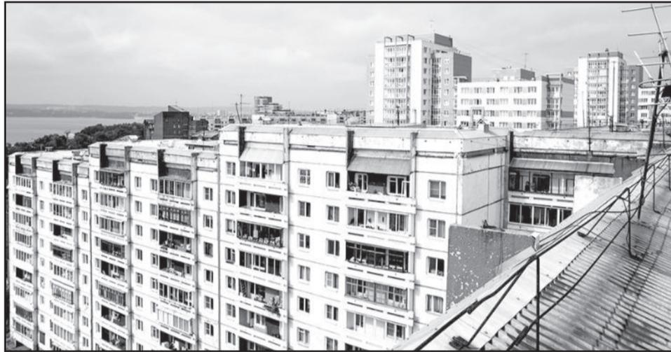
**В доме №13 на улице Маршала Жукова кровлю обновляли меньше десяти лет назад. Несмотря на цельность конструкции, жителей девятого этажа топит. Узкие ендовы и водосборный лоток не справляются с нагрузкой, отсутствуют необходимые примыкания и соединение лотка с пластиковой частью водоотвода. За счет текущего ремонта собственники дома отремонтировали кровли в четырех блок-секциях из одиннадцати. Оставшиеся семь, они надеются, будут заменены региональным оператором в рамках капремонта дома.**
