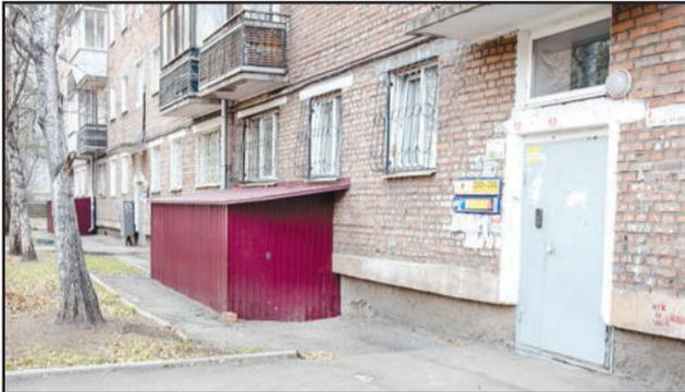
Главное требование жителей дома №75 на ул. Трудовой было закрыть доступ в подвальные приямки для асоциальных лиц. В итоге убрали развалившиеся бетонные блоки, поставили металлокаркас и обшили его профлистом. К стене сделали примыкание. Для большей шумоизоляции на крышу под профлист можно класть фанеру или OSB-плиты. Данный вид ремонта можно делать при любой комфортной для работы погоде, в том числе и осенью.
