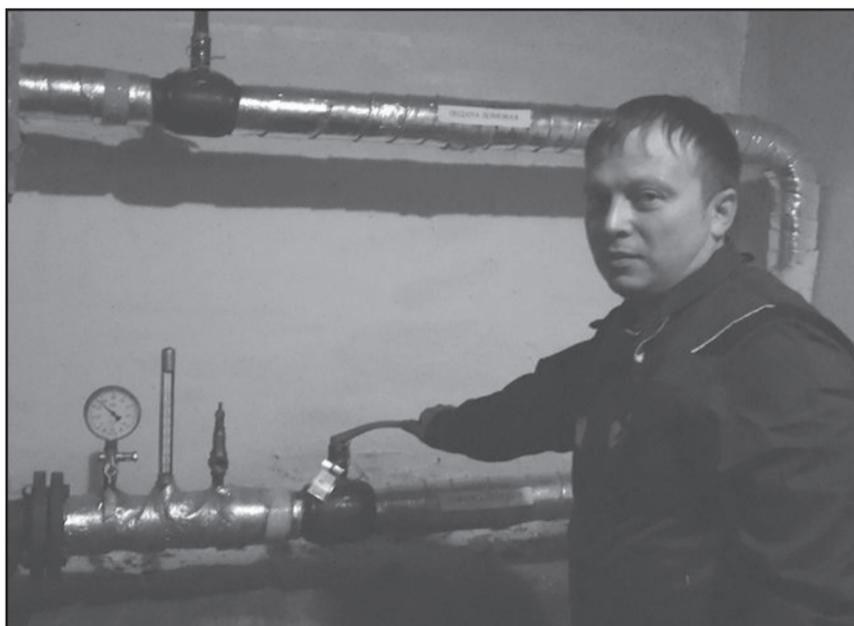
*Мастер участка Игорь Лазарев открывает задвижку в элеваторном узле. С этого момента горячая вода начинает циркулировать по теплосистеме внутри дома. Чтобы она заполнила все трубы в стандартной пятиэтажке, требуется около полутора часов.*
