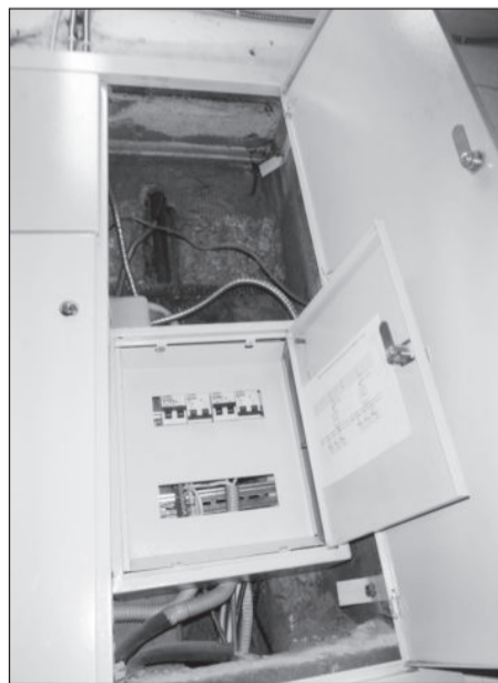
А так – где уже произошел ремонт системы электроснабжения. Теперь здесь не только красиво, но и безопасно
