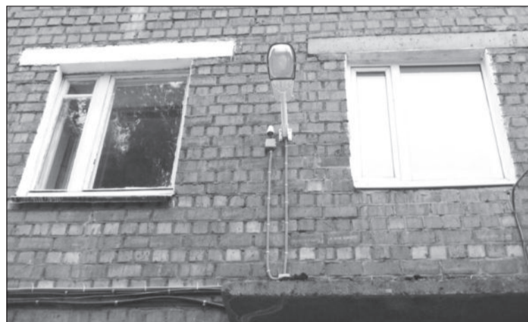
Это не простой, а умный фонарь, такие фонари с фотореле установлены над подъездами дома № 15 на ул. Депутатской. Вечером они сами зажигаются, утром – гаснут
